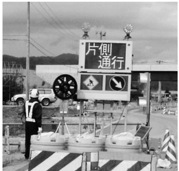
写真-1 従来型の誘導標示板による規制
