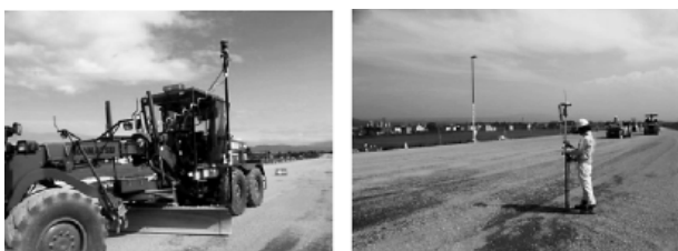
写真-2 自動制御による施工状況
