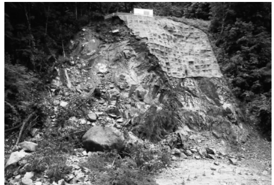
写真-1 岩盤崩落後の状況
