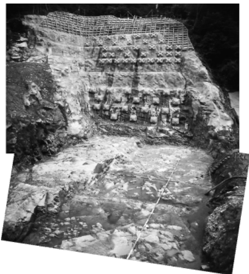
写真-6 抑止工、床掘り完了状況
