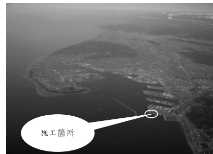
写真-2 清水港（東側より望む）
