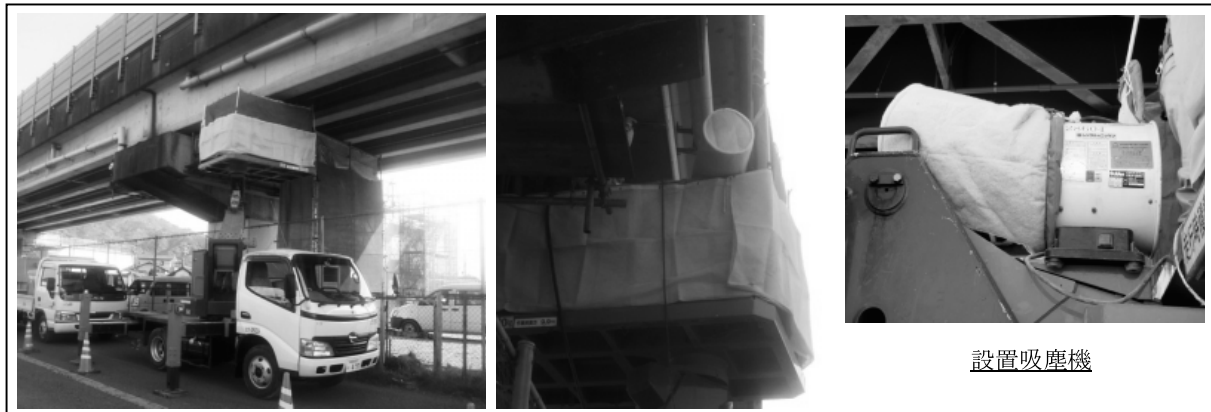
写真-8 粉塵の抑制対策
