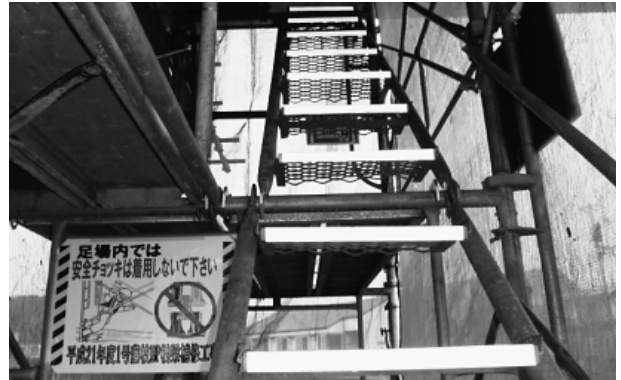
写真-4 反射テープ設置
