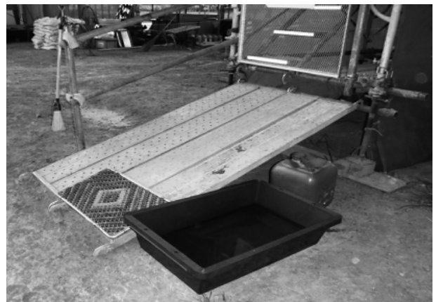
写真-6 足元滑り事故、粉塵対策
