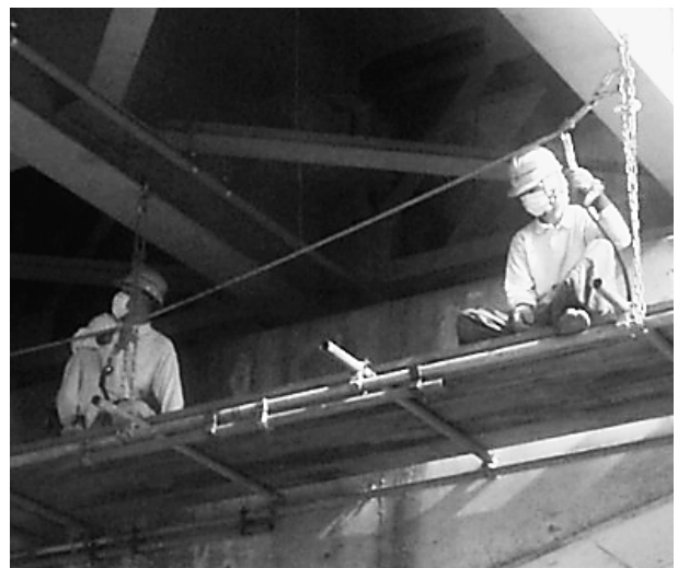
写真-1 通常の親綱設置状況
