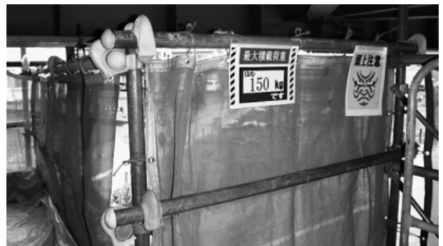
写真-5 クランプカバー及び単管キャップ取付
