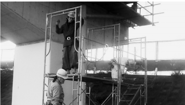
写真-3 桝組（昇降）足場の組み立て
