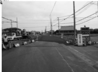
写真-3 2回目交差点分割 施工中・基層にて 車道開放状況
