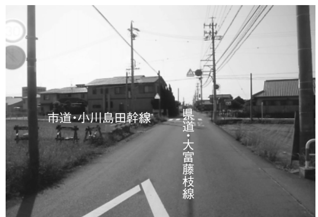
写真-1 交差点着工前
