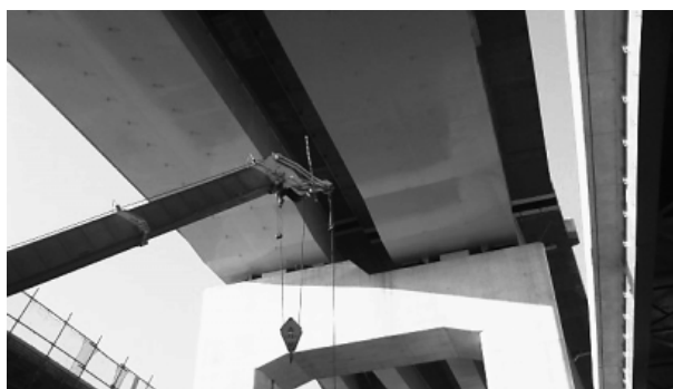
写真-2 桁下作業状況
