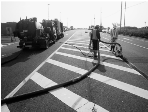
写真-2 区画線消去状況
