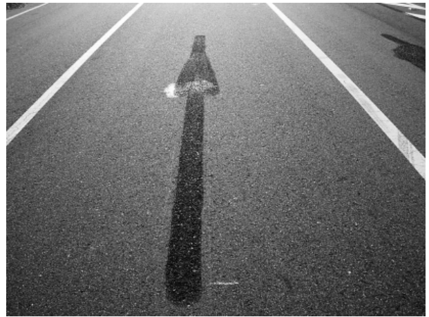
写真-3 区画線消去完了
