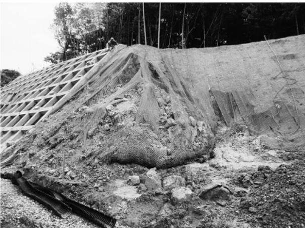
写真-1 法面崩落状況
