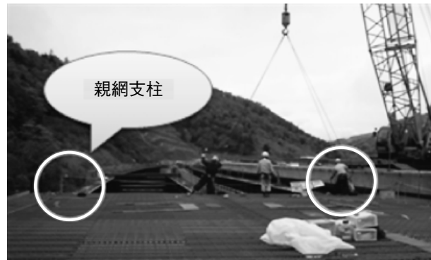
写真-4 親綱支柱使用状況
