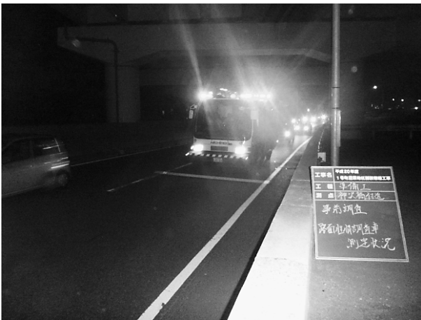
写真-3 事前調査状況
