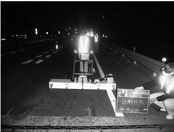
写真-2 事前調査状況
