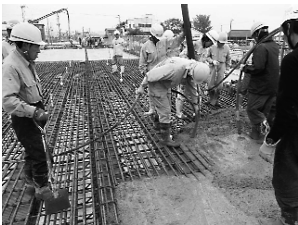
写真-1 コンクリート打設状況
