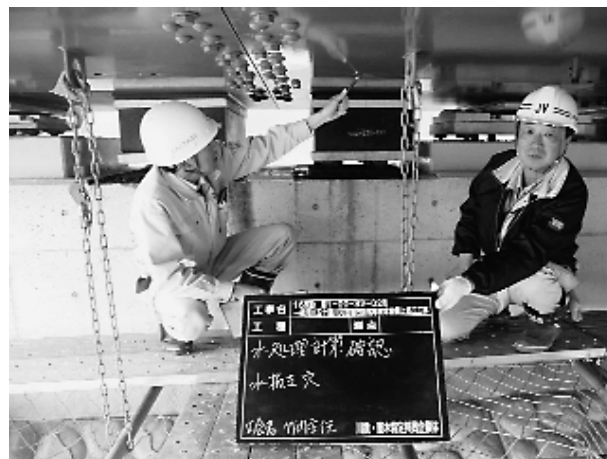
写真-3 水抜き主穴
