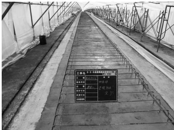
写真-1 防水層設置状況
