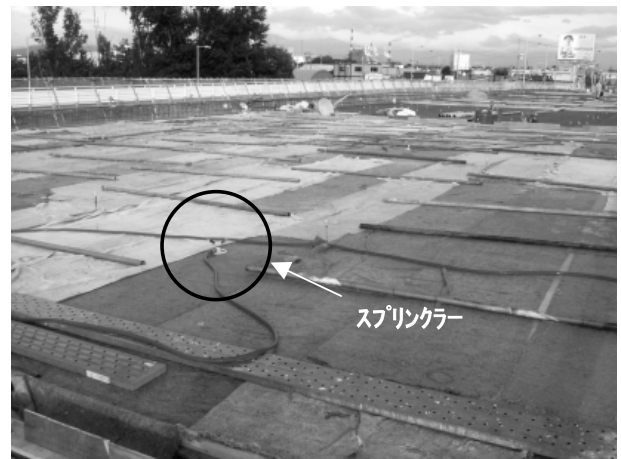
写真-2 スプリンクラーによる24時間散水状況
