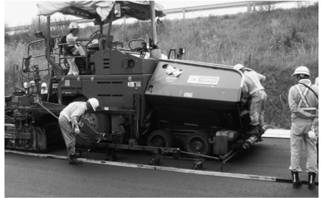
写真-2 路面感知方式敷きならし厚制御装置
