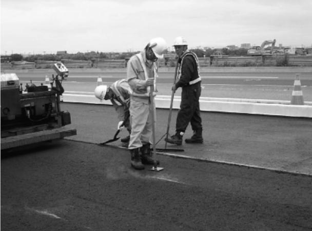
写真-3 タンパ締め固め状況
