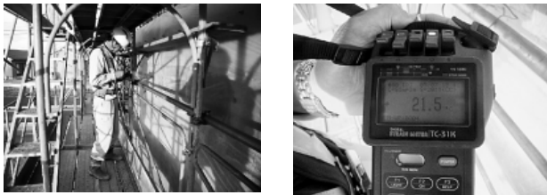
写真-2 内部温度測定状況
