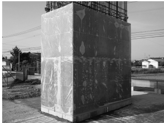
写真-5 ポリフィルム養生
