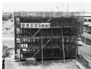
写真-4 (中期養生)
