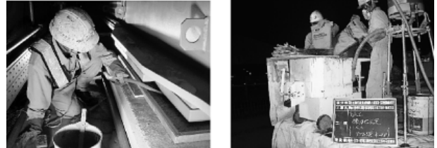
写真-1 グラウト状況写真
