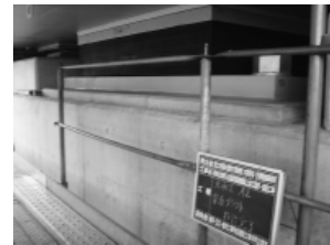
写真-2 グラウト完了写真
