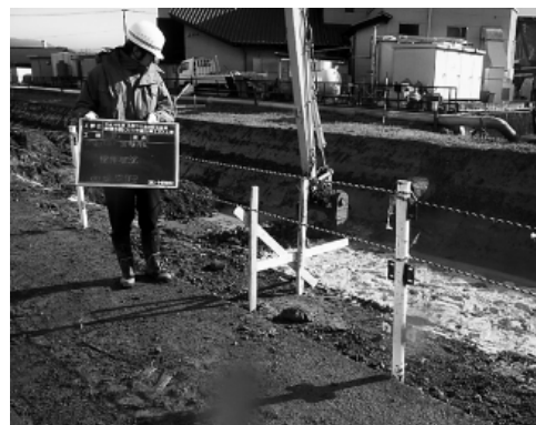
写真-1 バックホウ（攪拌機仕様）攪拌状況
