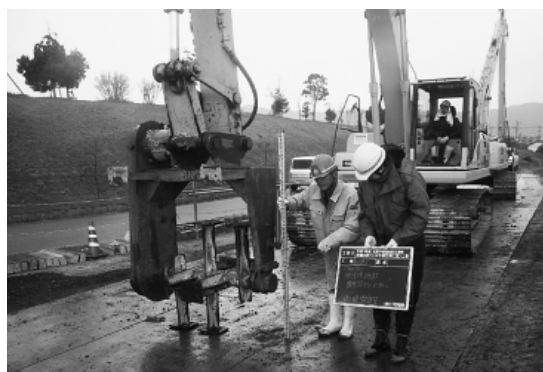
写真-2 攪拌ロッドにキャッチクランプ設置
