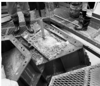
写真-2 バイブレーター締固め状況
