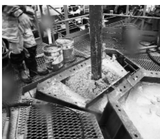
写真-4 生コン補充状況
