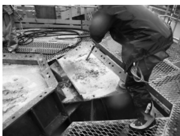
写真-5 スページング状況
