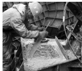
写真-7 蓋開後スページング状況
