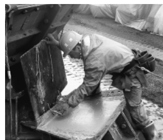
写真-8 蓋開後均し状況
