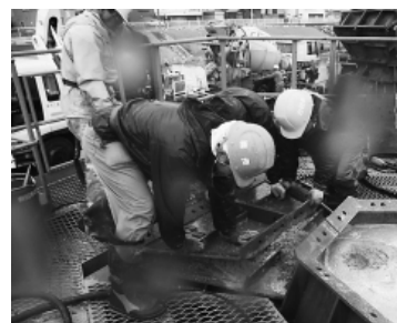
写真-6 型枠蓋設置状況
