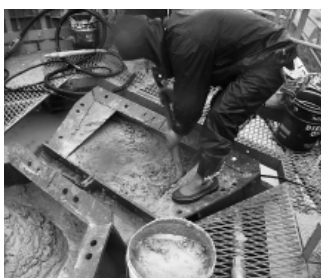
写真-3 モルタル分除去状況
