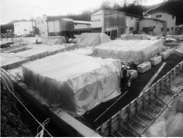
写真-1 防寒囲い設置状況（1次養生）
