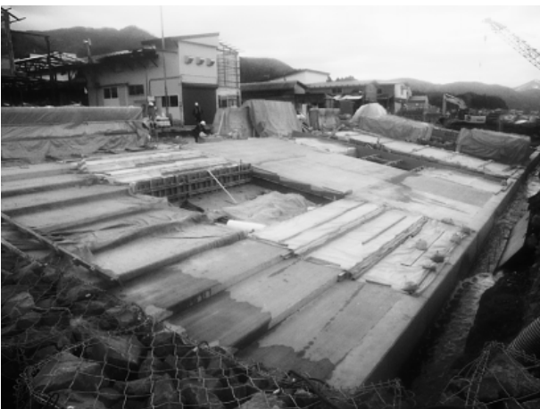
写真-2 シート養生状況（2次養生）
