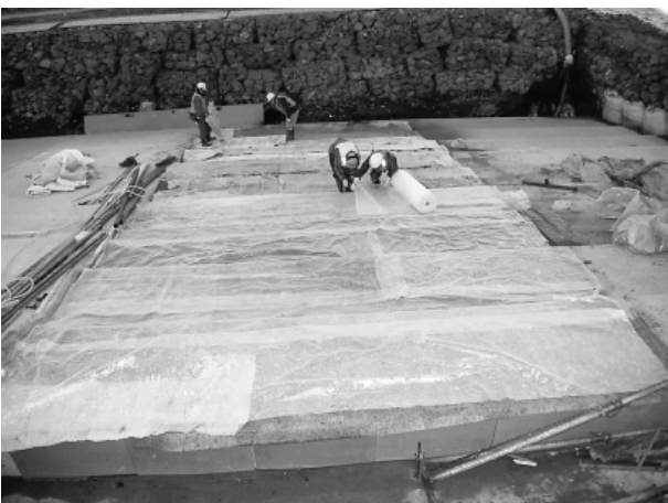
写真-3 養生シート・エアマット敷設
