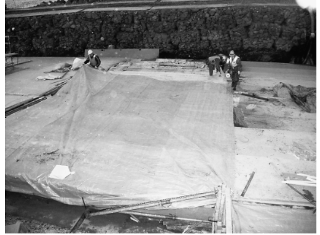
写真-4 ブルーシート敷設状況
