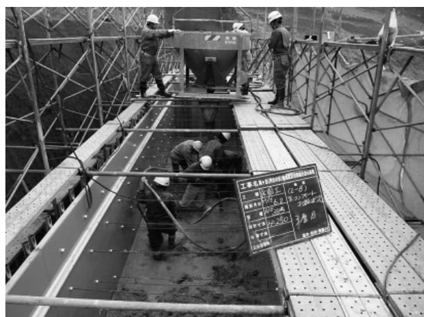
写真-2 3層目打設設況
