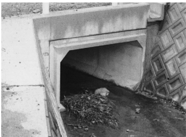
写真-2 二次製品使用 下流側
