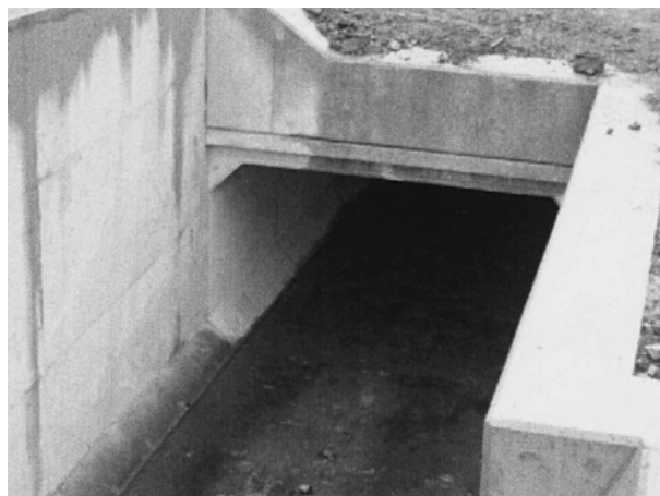
写真-3 二次製品使用 上流側
