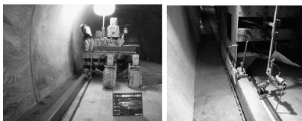
写真-1 打設状況 (左:全体、右:成型部拡大)
