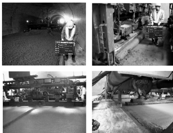
写真-3 可変勾配式舗設機械 (左上:スプレッダ、右上左下:フィニッシャ、右下レベラ)
