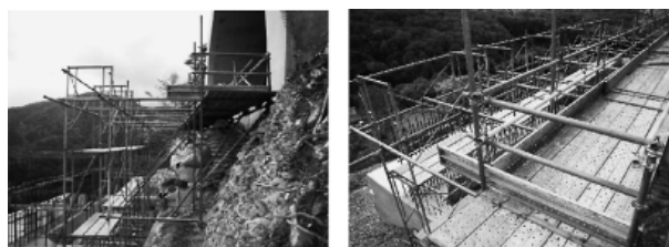
写真-4 仮設足場設置状況
