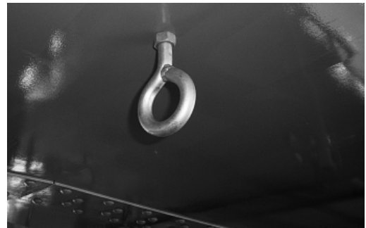
写真-1 吊りボルト
