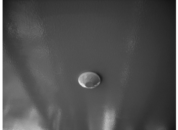
写真-4 閉ボルト塗装
