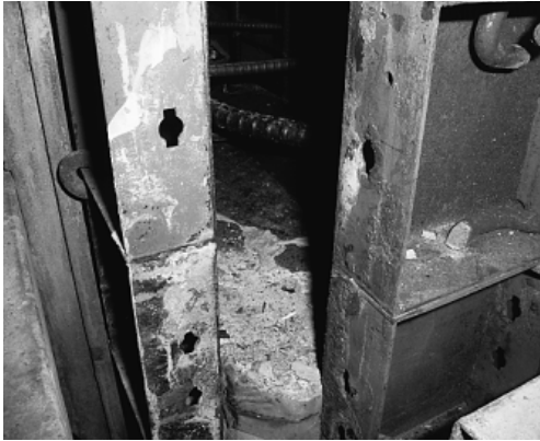
写真-3 側面型枠コーナーハンチ部除去状況
