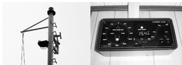
写真-2 外部設置風速計とデジタル表示部
