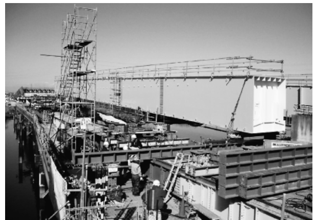
写真-2 横取り状況
