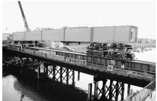
写真-1 桁縦送り状況
