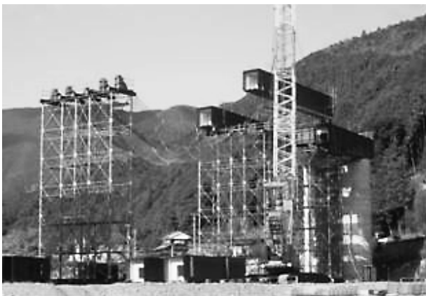
写真-3 P4～P3架設状況
