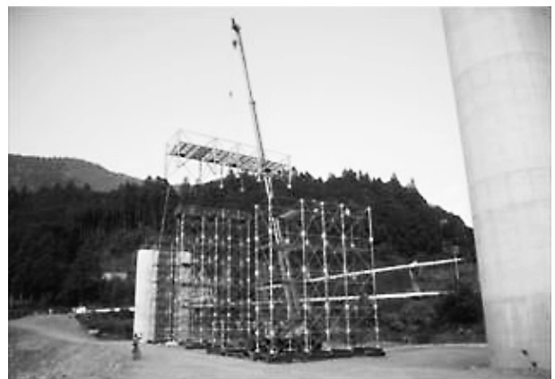
写真-1 RoRo システムベント
