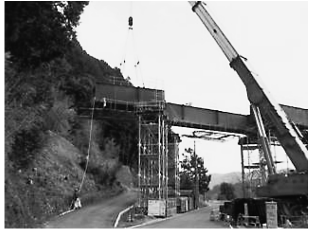
写真-4 P4～A2道路架設状況
