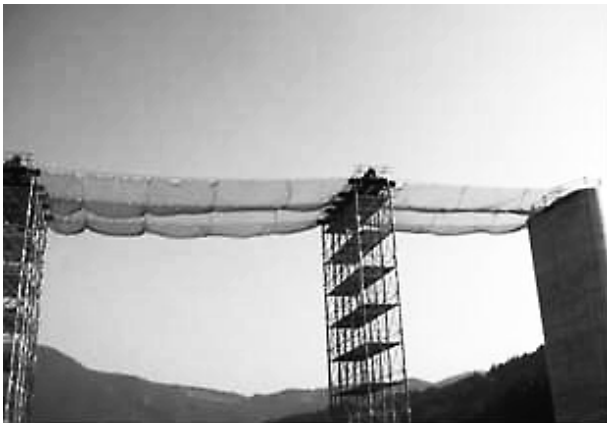
写真-2 墜落防止先行ネット
