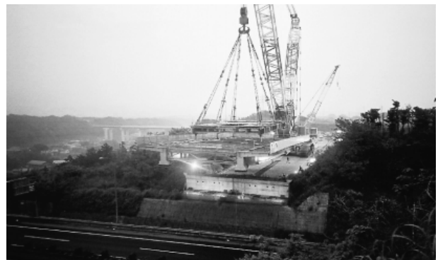
写真-4 架設状況
