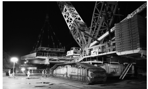
写真-3 架設準備完了
