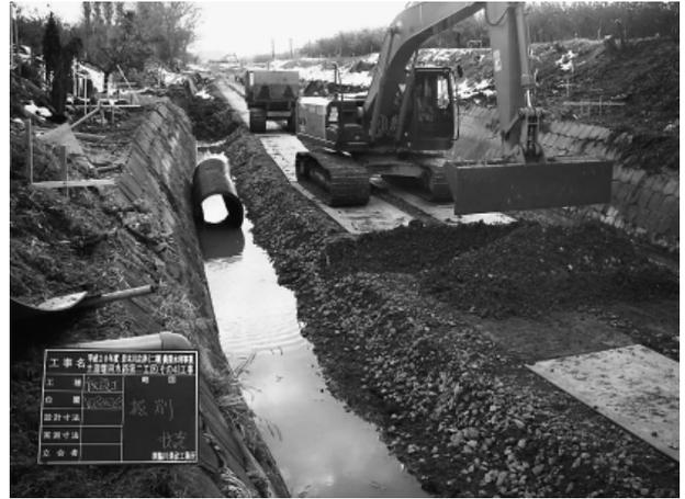
写真-1 耐圧ポリエチレン管φ1,000mm
