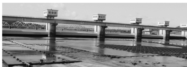
写真-1 既設護床工写真（撮影時ゲート調整）
