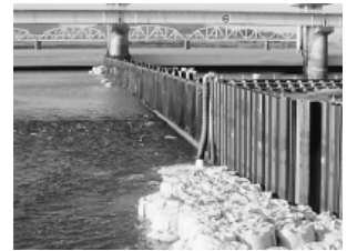
写真-3 仮締切堤外側
