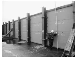
写真-2 仮締切堤内側
