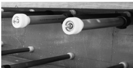
写真-1 被覆したセパレーター
