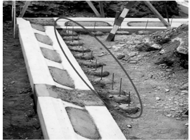
写真-1 コンクリート・差し筋（D13）
