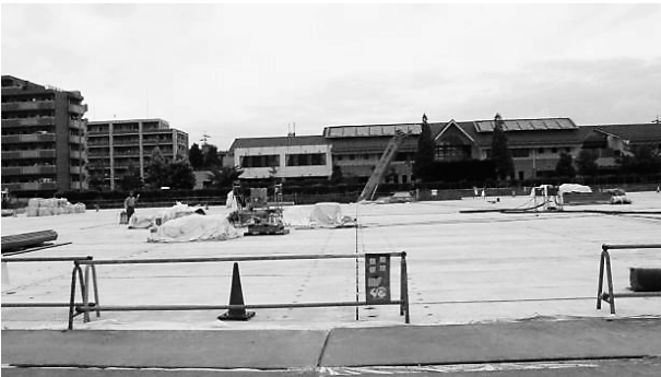
写真-2 調整池外部
