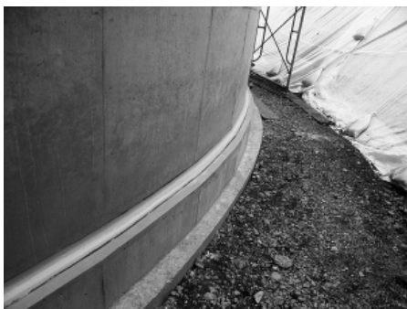
写真-1 ウレタン系防水材料塗布完了
