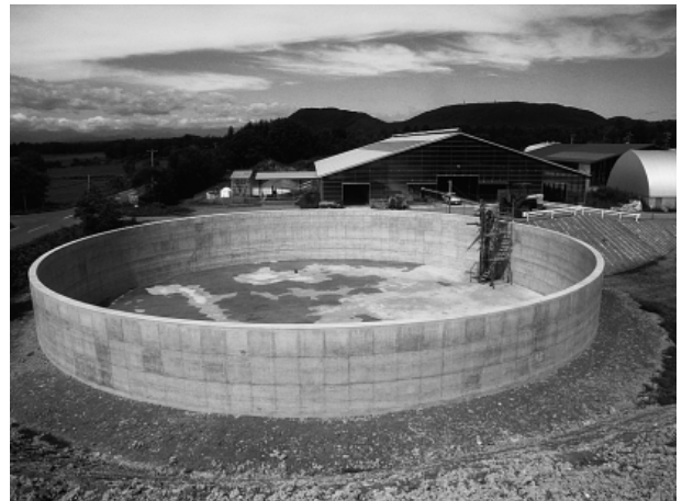
写真-3 完成写真(貯留槽)
