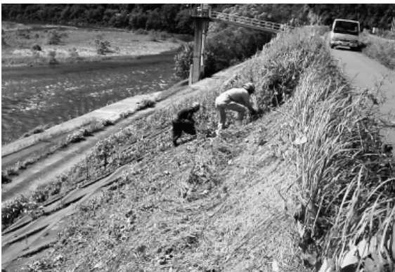
写真-2 連節ブロック部人力手刈作業
