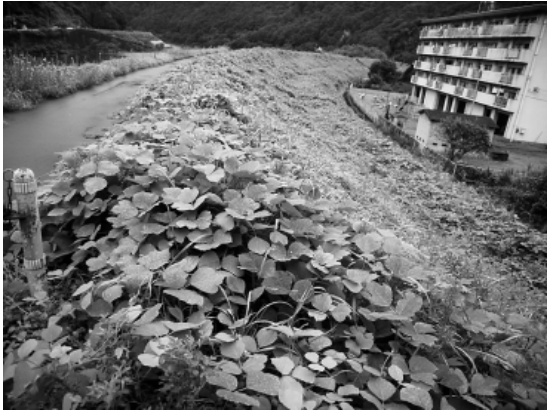
写真-1 川裏側法面に葛が繁茂
