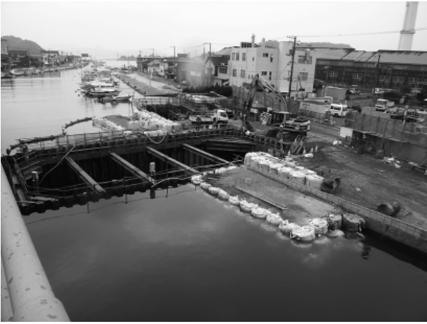
写真-2 満潮時の現場全体写真
