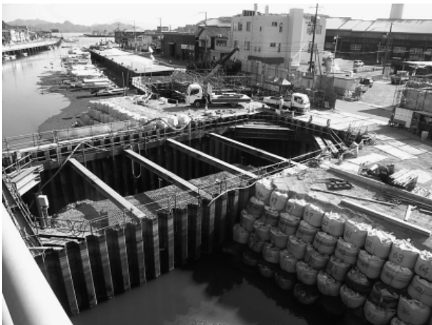
写真-1 干潮時の現場全体写真
