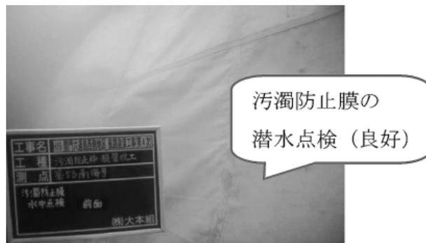
写真-1 汚濁防止膜の水中写真
