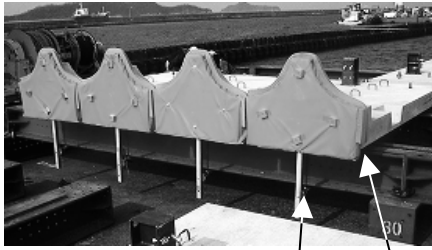
写真-1 底型枠セット状況（裏面）
