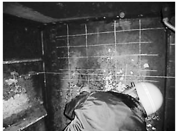
写真-2 端横桁の変状量調査
