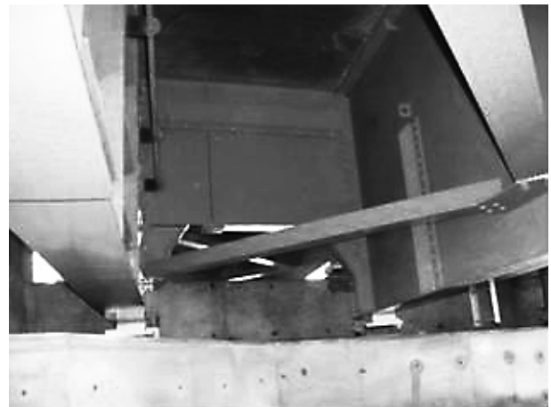
写真-5 端横桁・横構補修の完了状況
