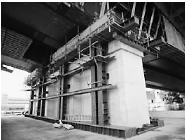
写真-2 仮受設備設置状況
