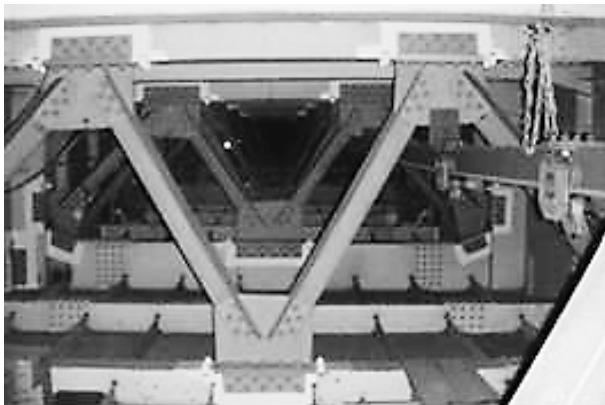
写真-1 桁内運搬設備（右上）
