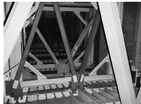
(a) トラス補強部の状況
