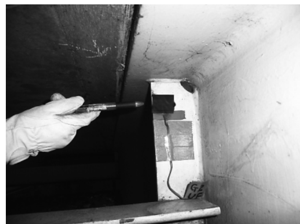
写真-3 測定箇所
