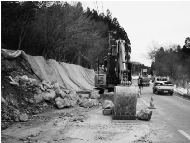
写真-1 被災箇所の撤去状況
