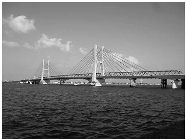
写真-3 完成写真
