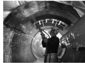
写真-4 耐硫酸モルタルの吹付け状況
