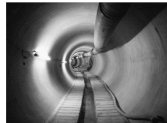
写真-5 完成後の全景
