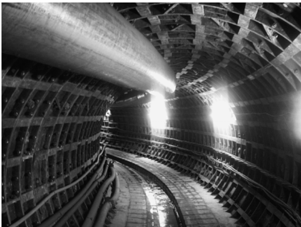
写真-1 鋼製セグメント区間の全景
