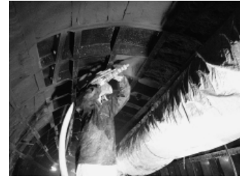
写真-3 充填モルタルの吹付け状況
