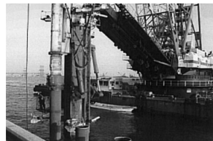
写真-1 鋼管杭打込み状況
