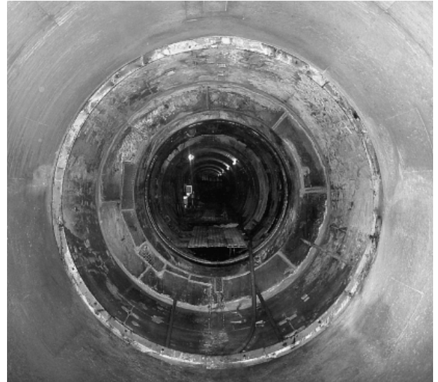
写真-6 シールド接続完了（フロ-⑪）
