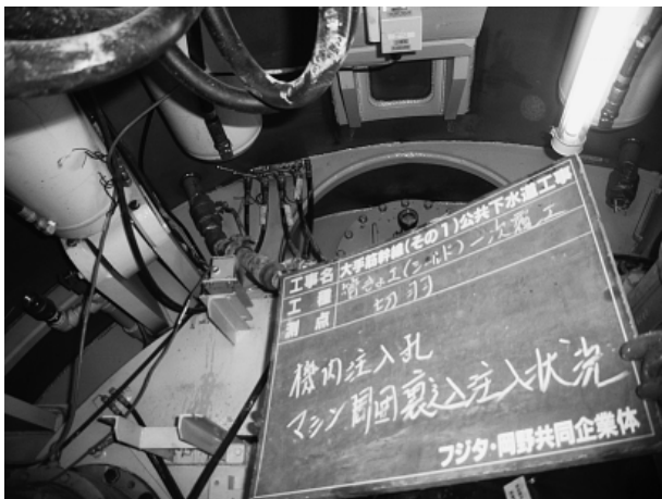
写真-1 機内注入状況
