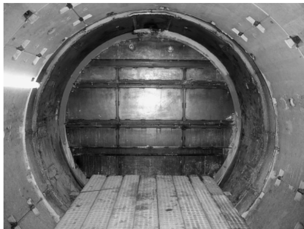
写真-4 機内充填完了(フロー④)
