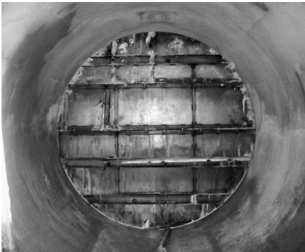
写真-5 機内充填完了（フロ-⑧）
