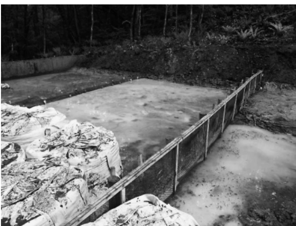
写真-5 仮設沈砂池
