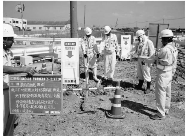
写真-6 埋設管位置図と管路マーキング
