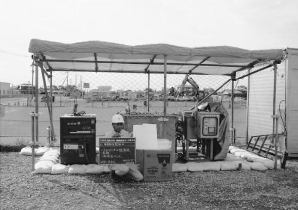
写真-4 水質汚濁対策（シート養生 防油堤設置）
