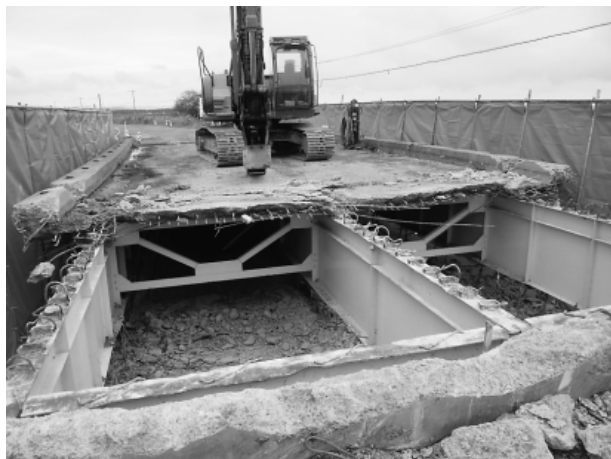
写真-5 桁下板張防護
