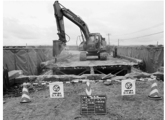
写真-1 大型ブレイカー
