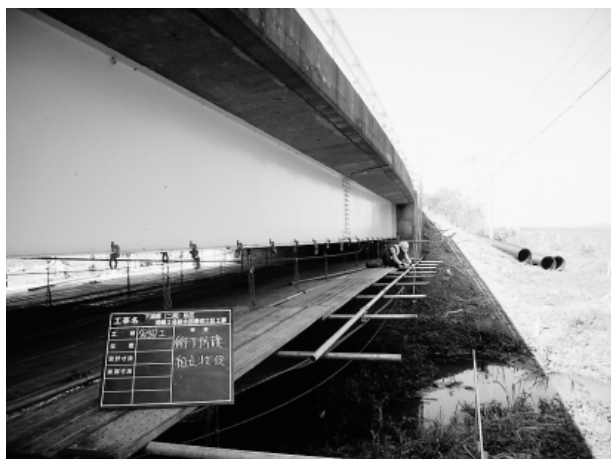
写真-4 桁下仮設状況
