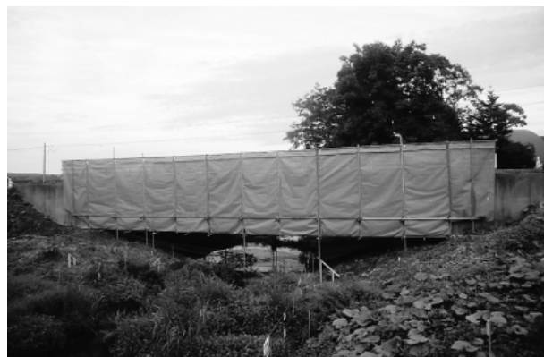
写真-6 粉塵・防音対策囲い
