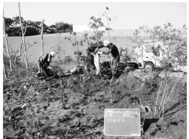
写真-4 低木採取・移植状況
