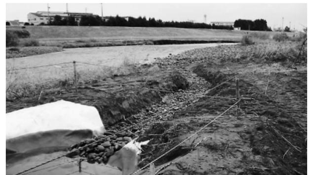
写真-6 沈砂池からの排水路写真
