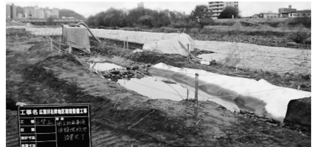
写真-5 ノッチタンクと沈砂池写真
